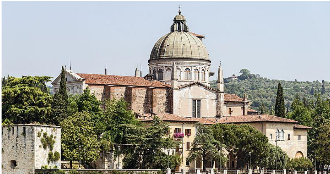
Prima dei lavori
